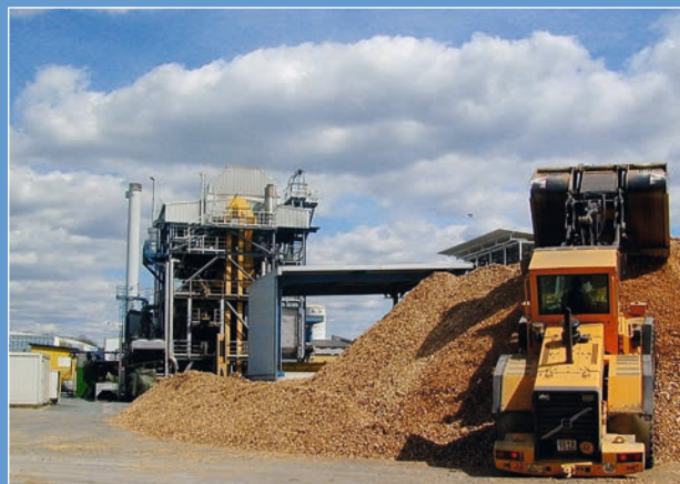
Figuur 11 Güssing-vergasser. Bron: Europäisches Zentrum für erneuerbare Energie Güssing GmbH
