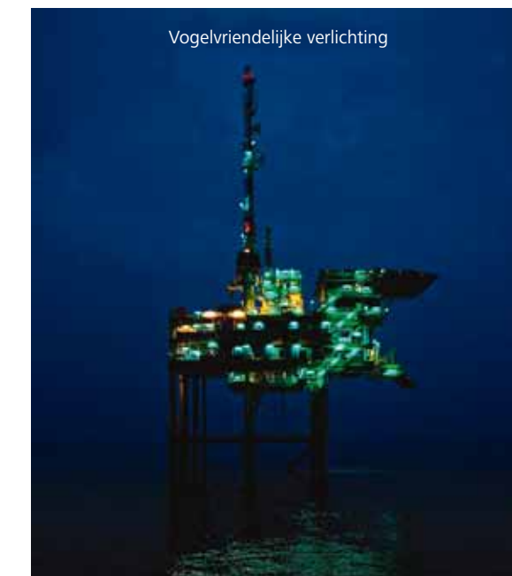
Foto's pagina 209 Een traditioneel verlicht boorplatform (links) desoriënteert trekvogels. Een platform met groene verlichting (rechts) verstoort het kompas van vogels minder.
