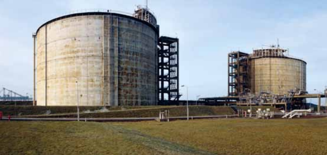
Foto's pagina 170 De tanks met vloeibaar aardgas van de Gasunie op de Maasvlakte bevatten een buffervoorraad vloeibaar aardgas van 75 miljoen kubieke meter, die gebruikt kan worden als in extreme winteromstandigheden de vraag naar aardgas sterk toeneemt.
