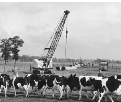
Foto's pagina 62 Het leggen van gastransport- leidingen door de weilanden vanwege de grootschalige uitbreiding van het leidingnet.
