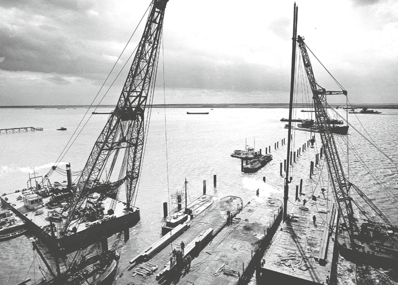
Foto pagina 64 Het leggen van leidingen door grote wateren vergt de nodige voorbereiding, zoals hier voor de Scheldekrusing in 1965. Zichtbaar is het heien van de laatste palen voor de montagebrug met daarop twee zinkerstukken. Deze worden getrokken vanuit de bouwplaats op Zandvliet en de werkdijk in het Verdronken Land van Saeftinge, waarna ze aan elkaar worden gelast.
