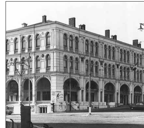
Foto pagina 54 Commissaris van de koningin in de provincie Groningen mr. Cees Fock, ontsteekt de gasvlam ter ere van het feit dat Hoogezand-Sappemeer op 6 december 1963 als eerste gemeente is aangesloten op het gasnet uit Slochteren.
