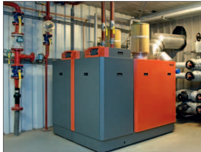
Figuur 5 Voorbeeld van een staande HR-ketel. Bron: Anita Pantius
