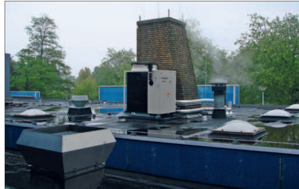
Figuur 11 Opstelling van de gasabsorptiewarmtepomp op het Sportfondsenbad in Didam. Bron: Sportfondsen Nederland
