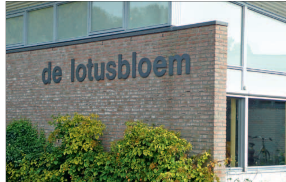
Figuur 9 Buitengevel zwembadgedeelte kinderdagcentrum. Bron: Techneco
