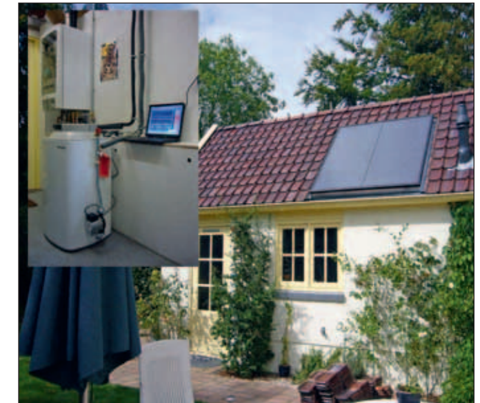
Figuur 11 Testopstelling micro-WKK (HRe-ketel). Bron: GasTerra
