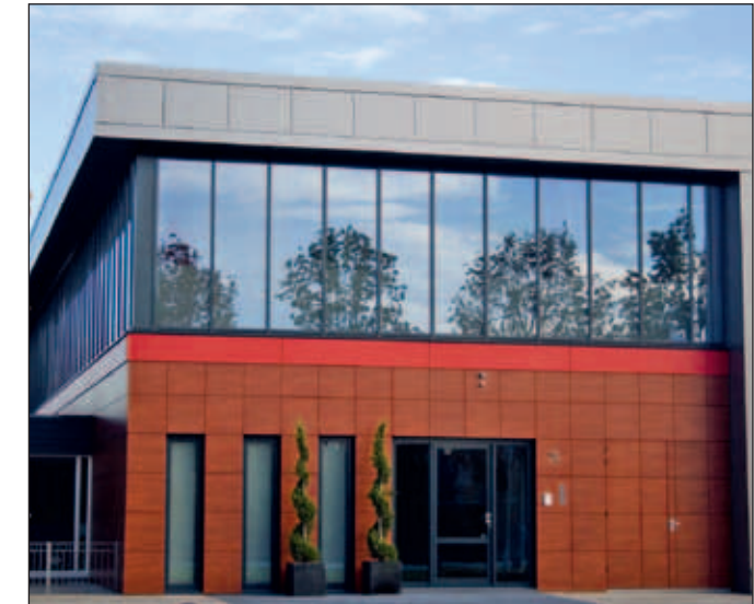
Figuur 13 Kantoorgebouw met gasmotorwarmtepomp (zie paragraaf 7.9). Bron: Gasengineering
