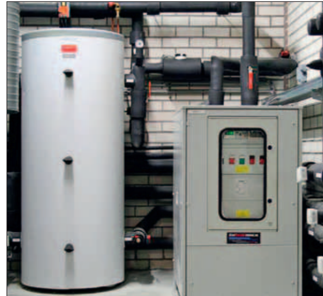
Figuur 16 Hydromodule voor toepassing bij een gasmotorwarmtepomp. Bron: Gasengineering
