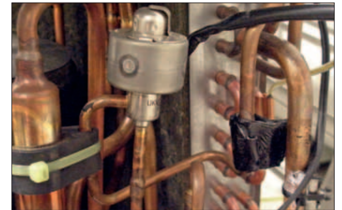
Figuur 19 Elektronisch expansieventiel. Bron: KGT
