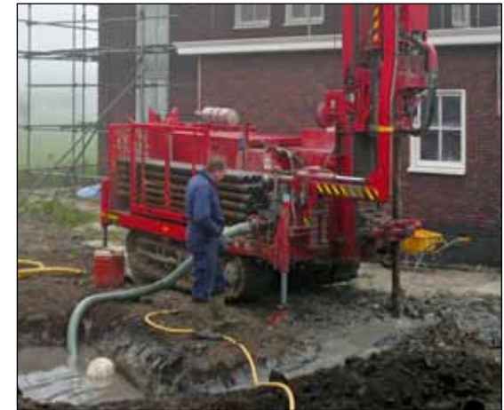
Figuur 18 Aanbrengen van een bodemwarmtewisselaar.
