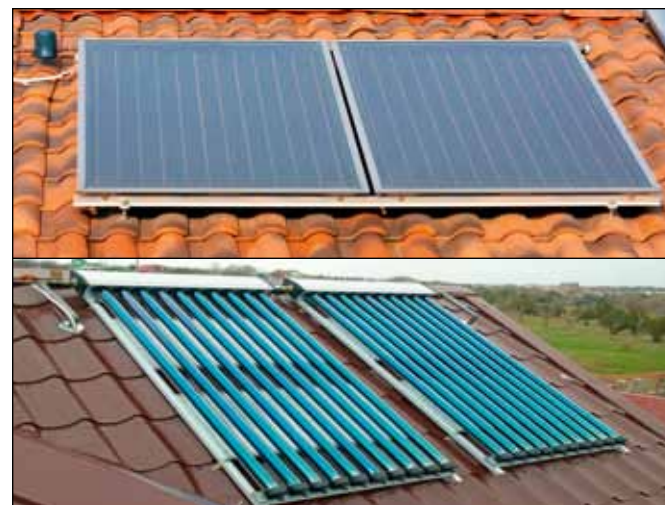
Figuur 1 Twee zonnecollectorsystemen. Boven een plaatcollector en onder vacuümbuisen. Foto: Shutterstock
