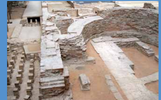
Figuur 2 Een hypocaustum werd in de klassieke beschavingen gebruikt om ruimtes te verwarmen door middel van hete rookgassen onder de vloer. Een open vuur in de ruimte was daardoor niet nodig. Foto: Shutterstock
