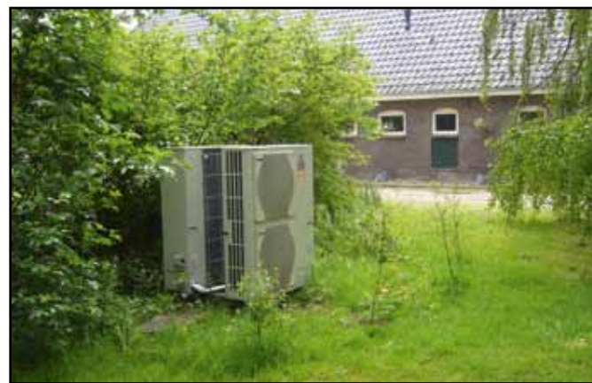
Figuur 16 Buitenunit van lucht/water-warmtepomp in split-uitvoering. Bron: HR Advies
