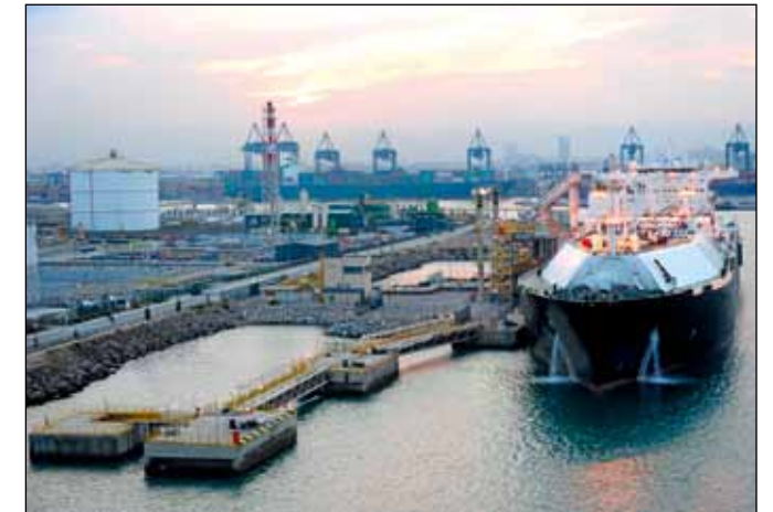
Figuur 8 LNG-installatie in Egypte. Bron: Shutterstock
