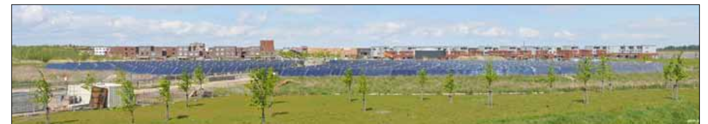
Figuur 4 Zoneiland in Almere. De warmte die door de collectoren wordt opgevangen, wordt direct in het stadswarmtenet gevoed. Vanuit het warmtenet kan de zonnewarmte dan worden ingezet voor zowel ruimteverwarming als warm water. In de praktijk zal de warmteproductie vooral in de zomer plaatsvinden, zodat het grootste deel van de zonnewarmte uiteindelijk voor de bereiding van warm water zal worden gebruikt. Bron: www.panopictures.nl
