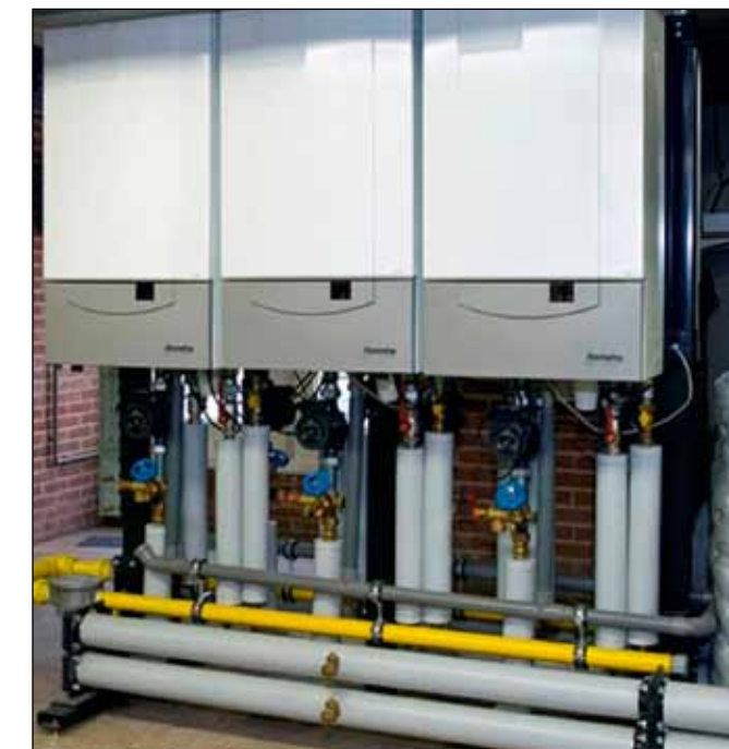
Figuur 3 Cascade van gaswandtoestellen. Foto: Anita Pantus
