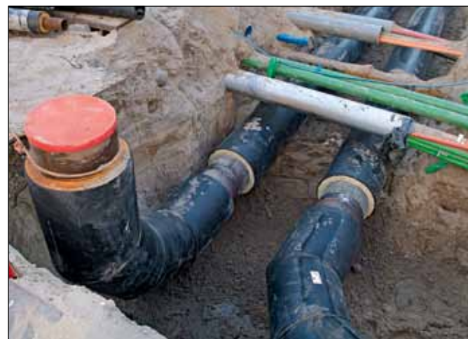
Figuur 5 Een warmtenet in aanleg. Foto: Essent, Riesjard Schropp
