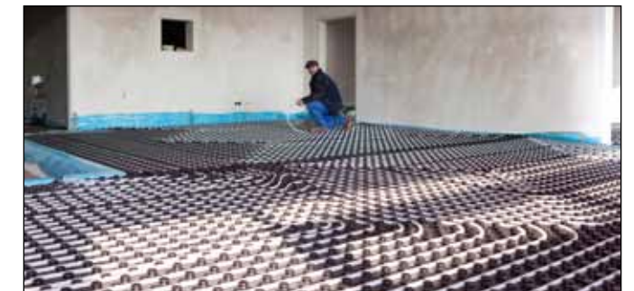
Figuur 6 Een vloerverwarmingssysteem in aanbouw. Foto: Shutterstock
