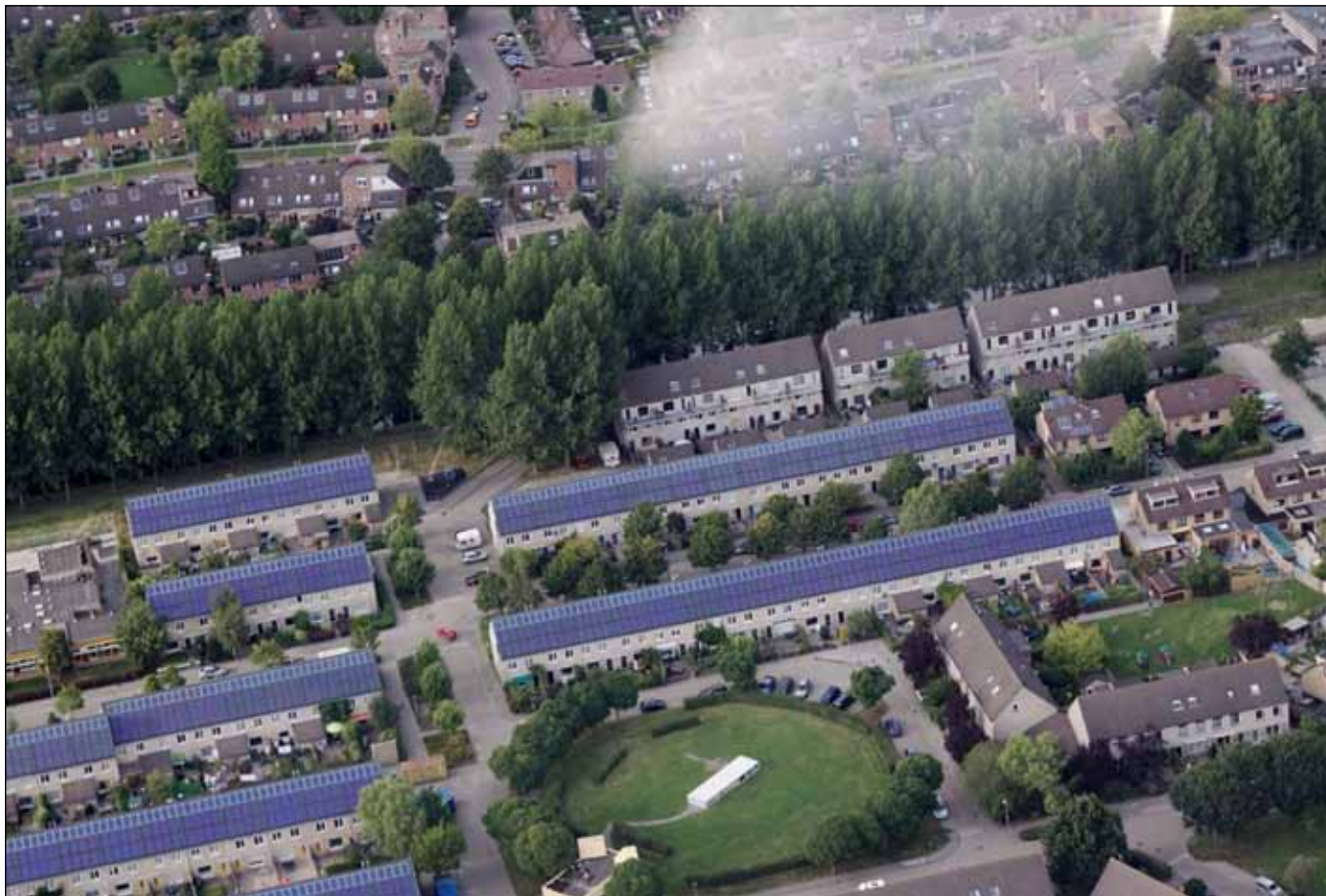
Figuur 11 Vanuit de lucht is de nieuwe situatie goed herkenbaar. Op de daken zijn de zonnecollectoren (de brede onderste strook op de daken) en de PV-panelen (de smalle bovenste strook op de daken) te herkennen. Onder het ronde grasveld is de centrale warmteopslag geplaatst.
