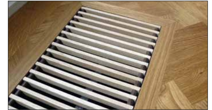
Figuur 5 Convectorput met radiator in een woning. Foto: TK Houten Vloeren
