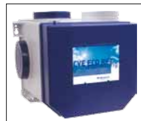
Figuur 23 Systeem voor mechanische (afzuig)ventilatie. Bron: Itho
